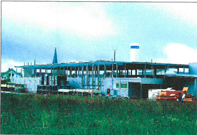
Firma Hochreiter, Bad Leonfelden in der Bauphase
